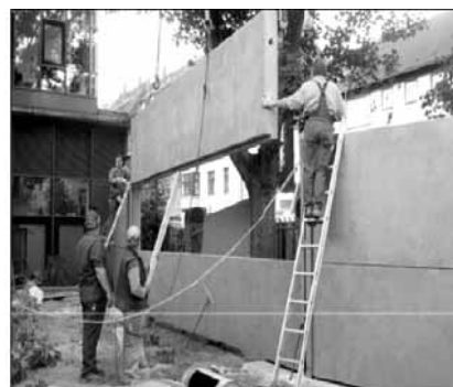
استفاده از سپرهای ضد انفجار پوششی برای حفاظت از یک ساختمان بزرگ
